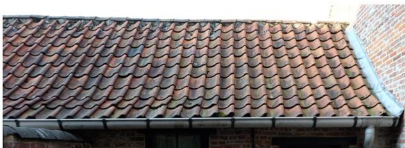
Dak voorgevel bijgebouw
