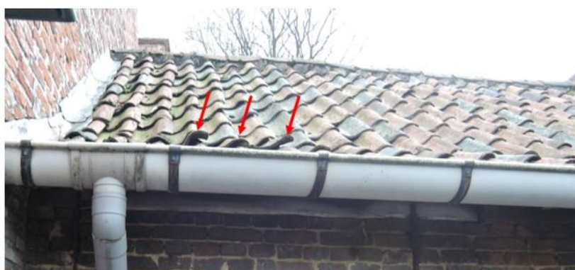
Dak achtergevel bijgebouw
