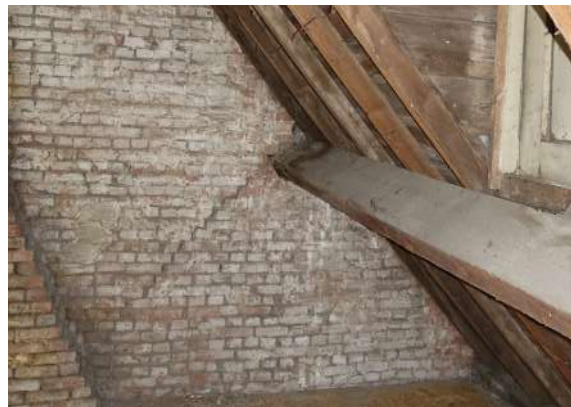
afb. 90: Zettingsscheur en gedegradeerde kaleilaag
