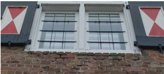
afb. 59: Gedegradieerd beigeleurig voegwerk, voorgevel.
