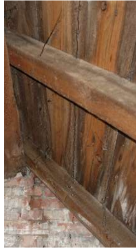
afb. 88: Erg roestig dakvlakvenster (zolder) en aangetaste bebording.
