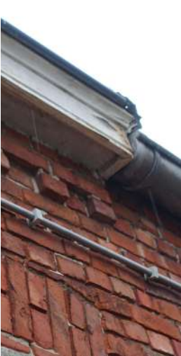
afb. 64: Ingerot buitenschrijnwerk en afschilferende verflaag kroonlijst.
