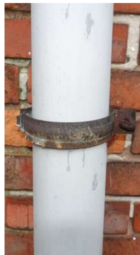
afb. 68: Verroeste ijzeren onderdelen.
