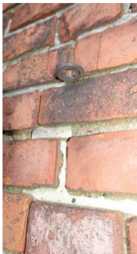
afb. 68: Verroeste ijzeren onderdelen.
