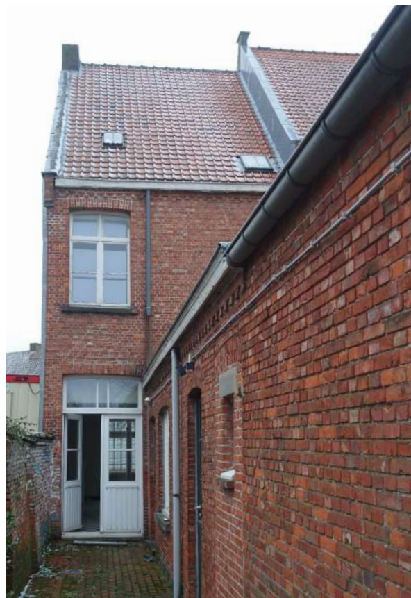
afb. 35: Achtergevel en aanbouw.
