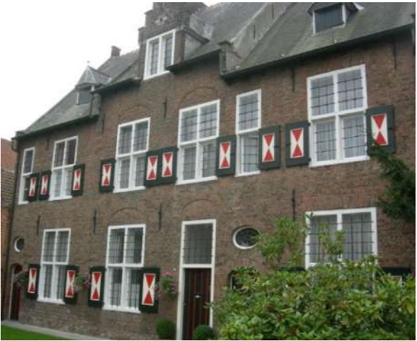
afb. 22: Foto van eenheidsbebouwing woningen nrs. 3,4 en 5 © ARAT architecten.
