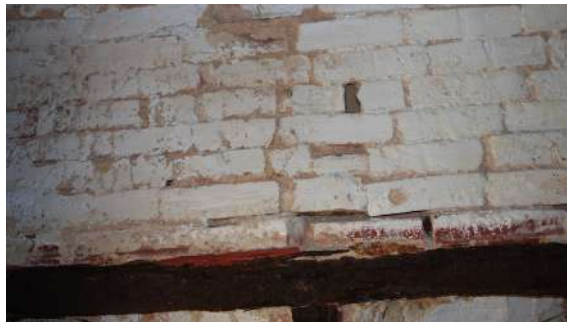
afb. 75: Kelder: vochtplekken, roestige ijzeren liggers en afschilferende pleisterlaag, huidige toestand 2025.
