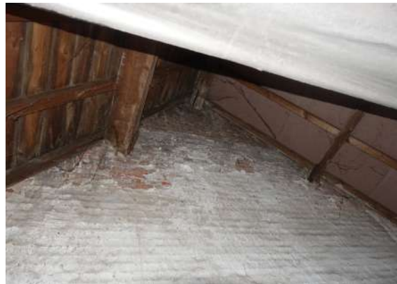
afb. 88: Erg roestig dakvlakvenster (zolder) en aangetaste bebording.
