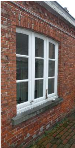
afb. 64: Ingerot buitenschrijnwerk en afschilferende verflaag kroonlijst.
