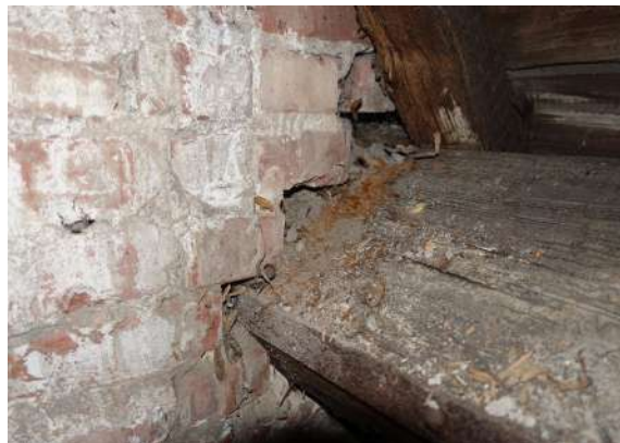
afb. 89: Aangetaste gordingen.
