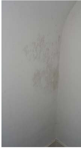
afb. 87: Scheuren en vochtplekken op pleisterlagen (zolderverdieping)
