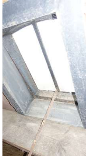
afb. 88: Erg roestig dakvlakvenster (zolder) en aangetaste bebording.
