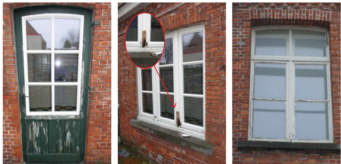
afb. 74: Ingerot houtwerk
