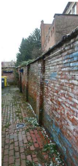
afb. 66: Scheur in bakstenen parament achtergevel, uitgespoeld voegwerk en ingevallen bakstenen tuinmuur.
