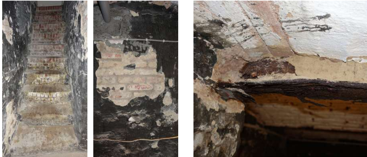
afb. 75: Kelder: vochtplekken, roestige ijzeren liggers en afschilferende pleisterlaag, huidige toestand 2025.
