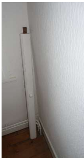
afb. 85: Scheur in pleisterwerk en uitneembare makelaar.
