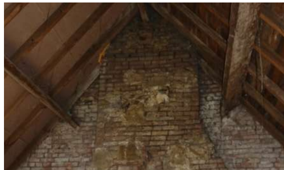
afb. 90: Zettingsscheur en gedegradeerde kaleilaag
