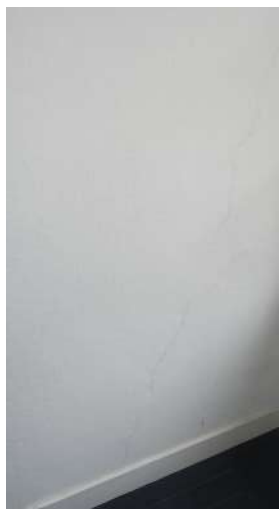
afb. 85: Scheur in pleisterwerk en uitneembare makelaar.
