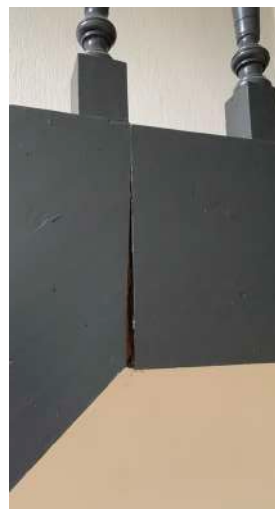
afb. 86: Scheur in panelen bij trappenhuis (zolderverdieping) en opening tussen plankenvloer - plint (slaapkamer).
