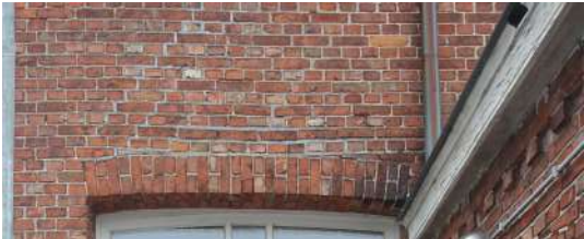
afb. 63: Herstellingen voegwerk met cementmortel.
