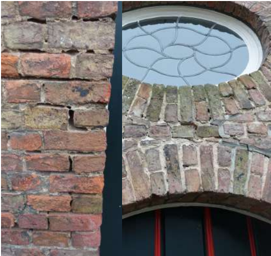
afb. 59: Gedegradieerd beigeleurig voegwerk, voorgevel.
