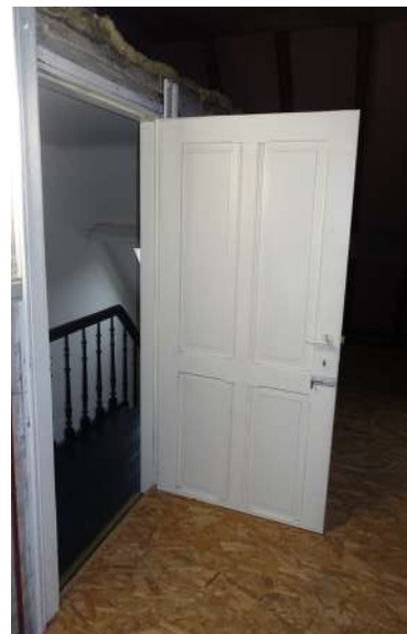
afb. 57: Zolderverdieping, huidige toestand februari 2025.
