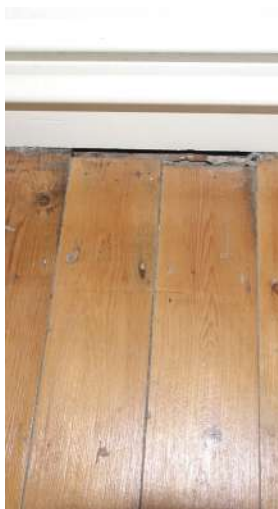
afb. 86: Scheur in panelen bij trappenhuis (zolderverdieping) en opening tussen plankenvloer - plint (slaapkamer).
