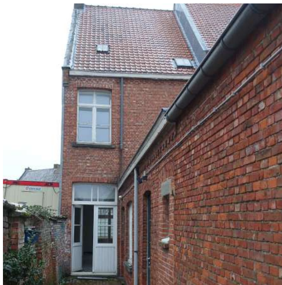
afb. 66: Scheur in bakstenen parament achtergevel, uitgespoeld voegwerk en ingevallen bakstenen tuinmuur.
