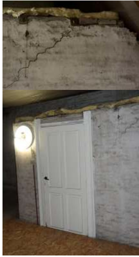
afb. 87: Scheuren en vochtplekken op pleisterlagen (zolderverdieping)
