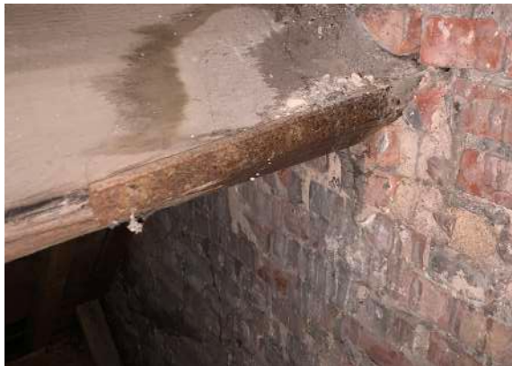
afb. 87: Scheuren en vochtplekken op pleisterlagen (zolderverdieping)
