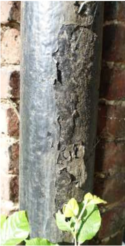
afb. 64: Verroeste onderdelen van ijzeren onderdelen: voetstuk regenafvoer en luikbeslag.
