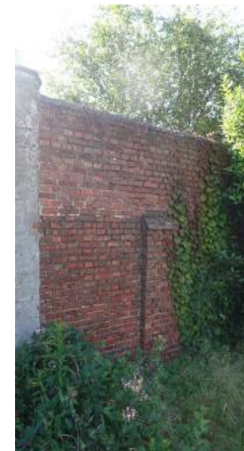
afb. 75: Verschaalde verflagen schrijnwerk (tuinberging) en uitgespoeld voegwerk tuinmuur.
