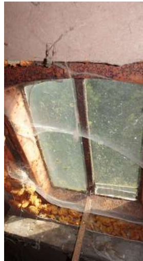
afb. 89: Erg roestig dakvlakvenster (zolder).
