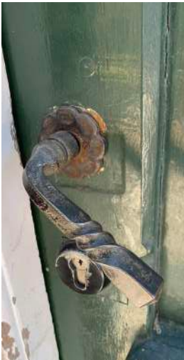
afb. 66: Verroeste onderdelen van ijzeren onderdelen: deurbeslag en voetschraper.
