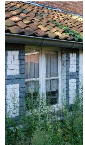
afb. 76: Verschaalde verflagen schrijnwerk en roestig deurbeslag (tuinberging).
