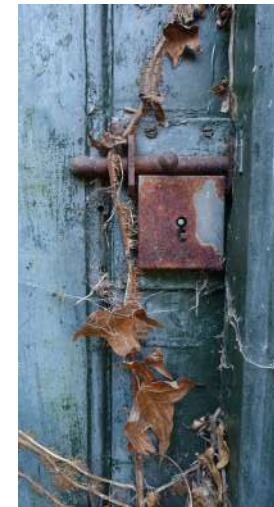
afb. 76: Verschaalde verflagen schrijnwerk en roestig deurbeslag (tuinberging).
