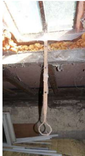
afb. 89: Erg roestig dakvlakvenster (zolder).
