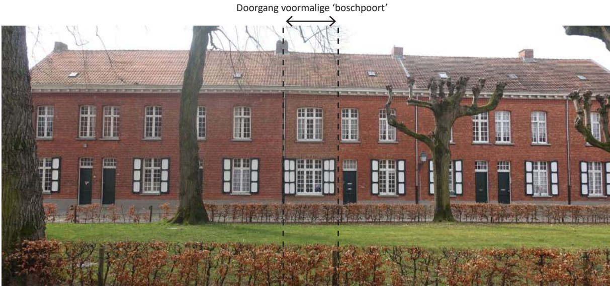
afb. 23: Huizenrij straatgevels: nrs. 11 t.e.m. 17 © Foto genomen in april 2022.
