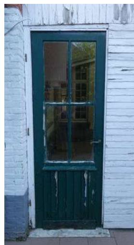
afb. 71: Verschaalde verflagen schrijnwerk.
