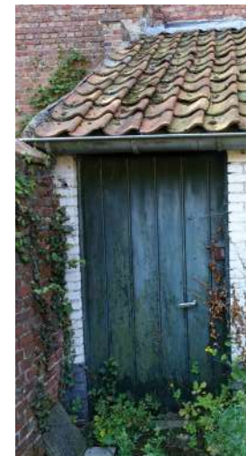
afb. 75: Verschaalde verflagen schrijnwerk (tuinberging) en uitgespoeld voegwerk tuinmuur.
