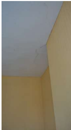
afb. 82: Scheuren in pleisterlagen (verdieping).
