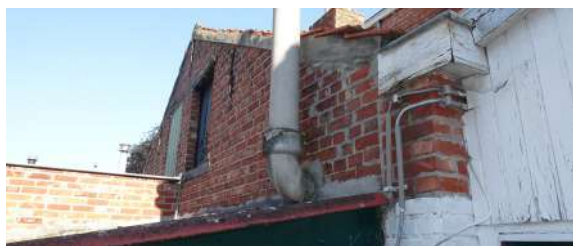
afb. 73: cementvoegwerk + verschaalde verflaag schrijnwerk
