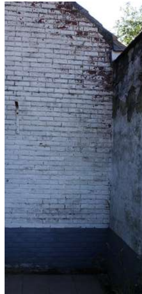
afb. 74: Verschaalde verflaag.
