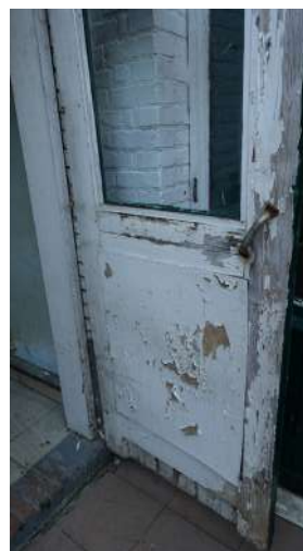
afb. 71: Verschaalde verflagen schrijnwerk.
