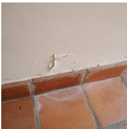
gelijkvloers hal: vermoedelijk lichte sporen van optrekkend vocht
