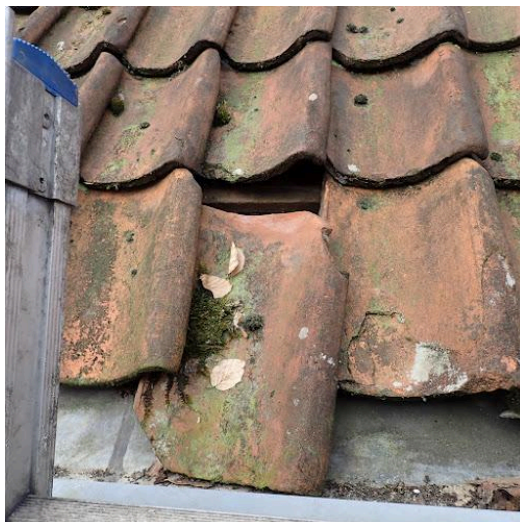
dak [2]-oost: uitgeschoven pan (teruggeplaatst door Monumentenwacht)
