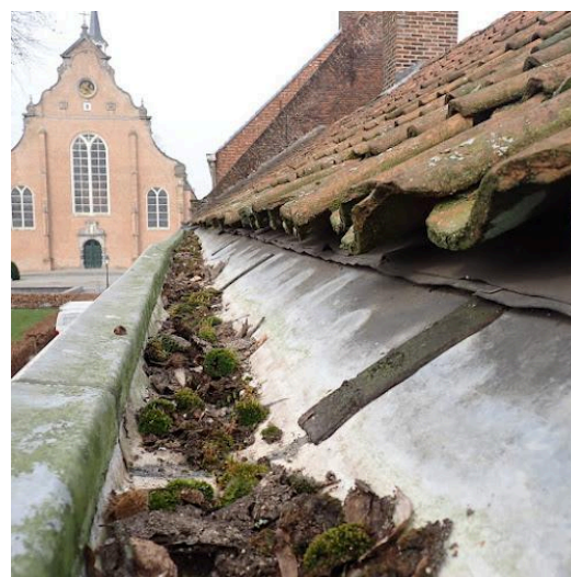
sterk verweerd zink en meerdere sterk verweerde roofing herstellingen
