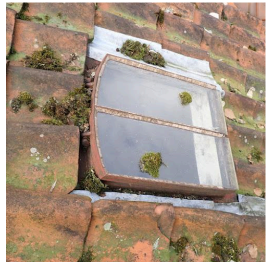
roestig dakvenster en wegvallende stopverf
