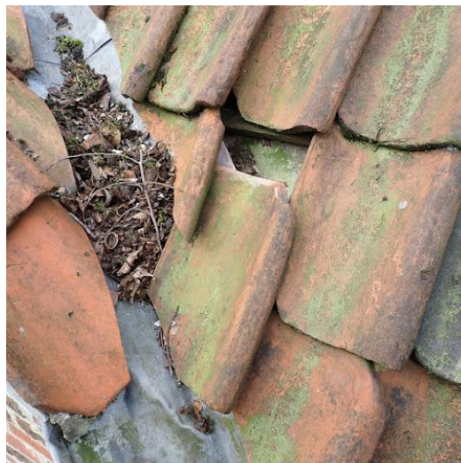
dak [2]-oost: uitgeschoven pan (teruggeplaatst door Monumentenwacht)
