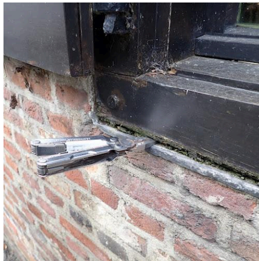
lood helt naar binnen met lichte inrotting tot gevolg
