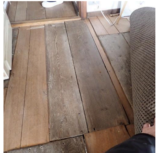
vernieuwde planken liggen naast elkaar zonder tand en groefverbinding waardoor ze iets meer doorbuigen
