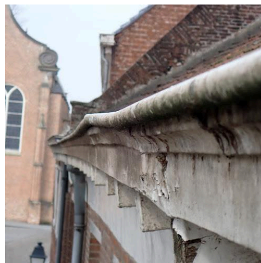
opgeplooide gootopstand
