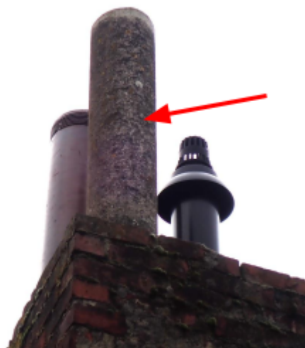
schoorsteenpijp asbesthoudend
