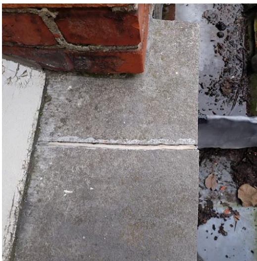
kit herstelling scheurt los
