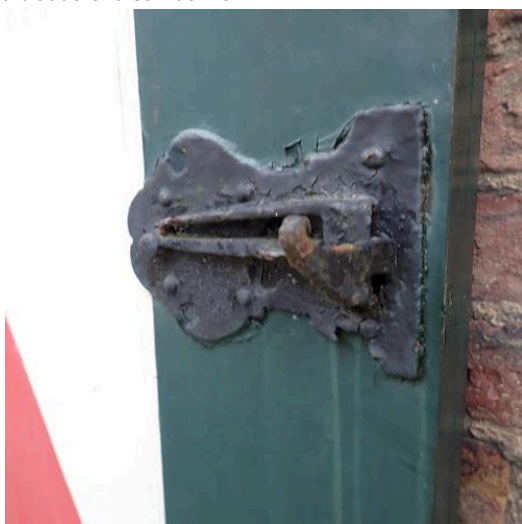
roestig sluitmechanisme
