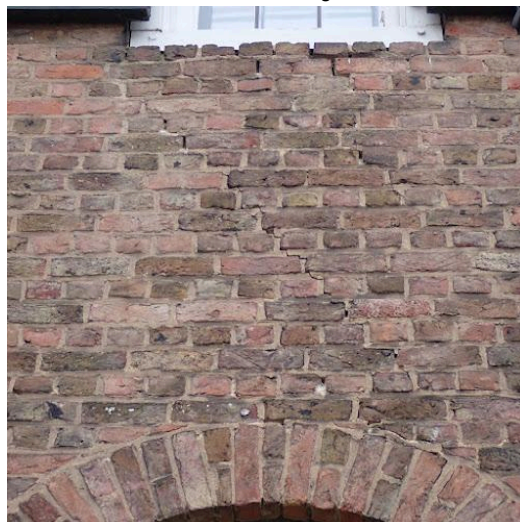
zettingsscheur
