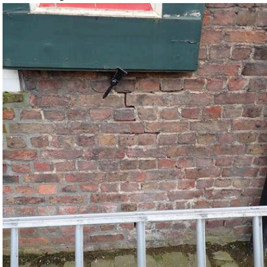
zettingsscheur
