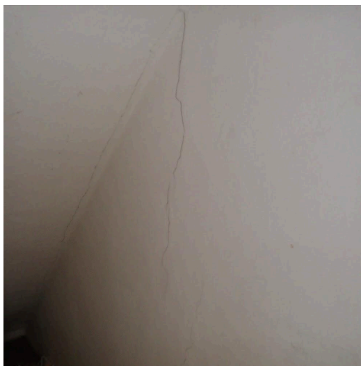
zettingsscheur kelder
