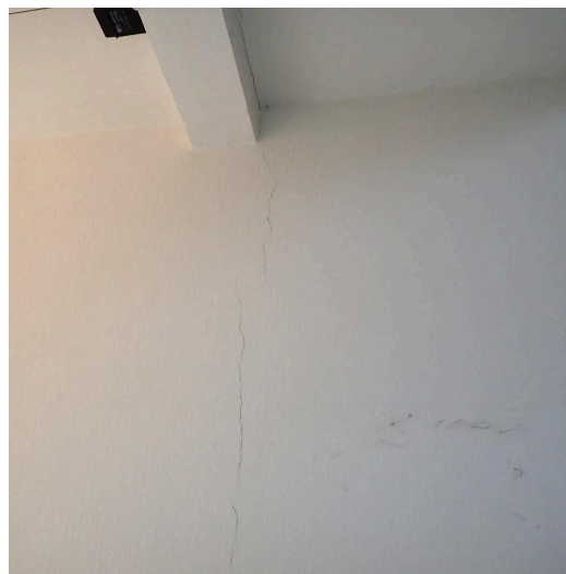
zettingsscheur gelijkvloers
