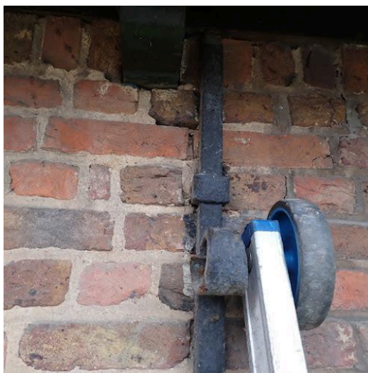
verschaald schilderwerk met beginnende roestvorming
