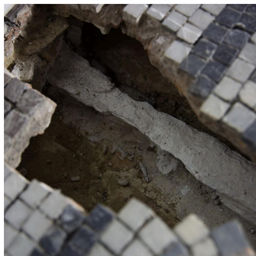
voorbeeld opengewerkte vloer met staalprofiel
