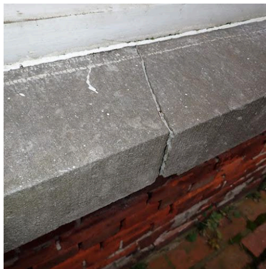
kit herstelling scheurt los
