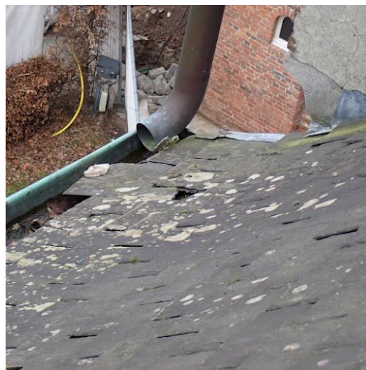
uitgeschoven en afgebroken leien
