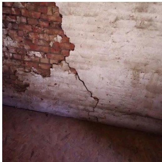
zolder zettingsscheur
