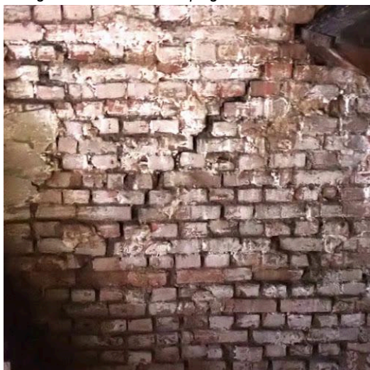
zolder zettingsscheur
