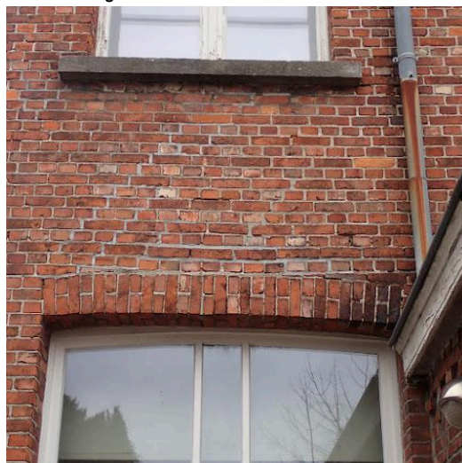
herstelde scheuren scheuren terug in
