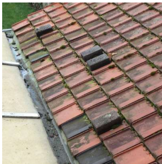
dak [2]: stenen op het dak
