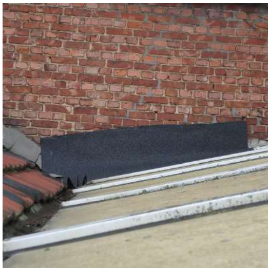
slordige herstelling met roofingslab
