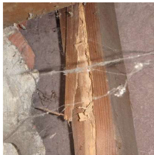
strijkkeper door huisboktor aangetast
