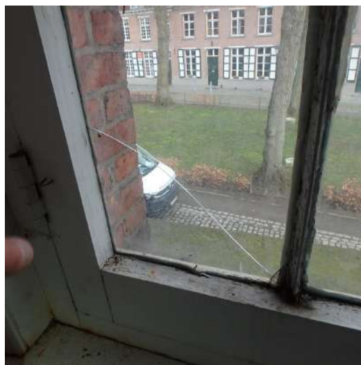
gebroken glaspaneel
