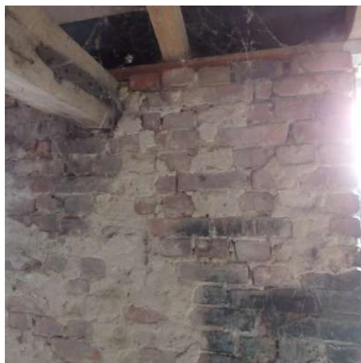
vleugel [5]: zettingsscheur
