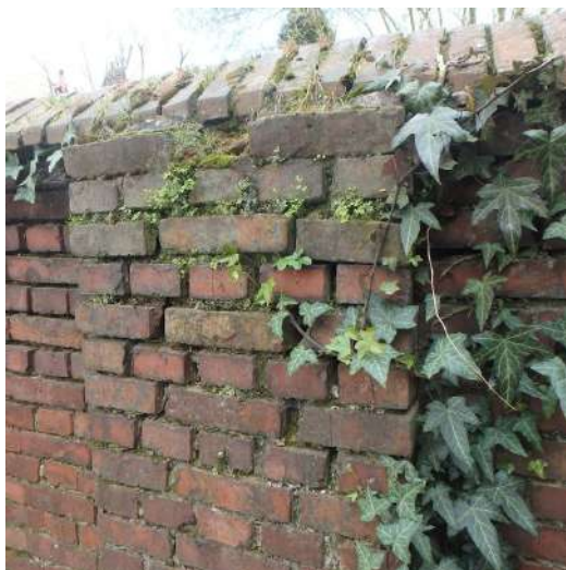
stenen worden weggedrukt en liggen los
