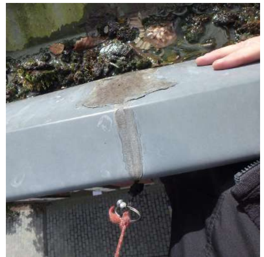
straatzijde: herstelling scheurt in
