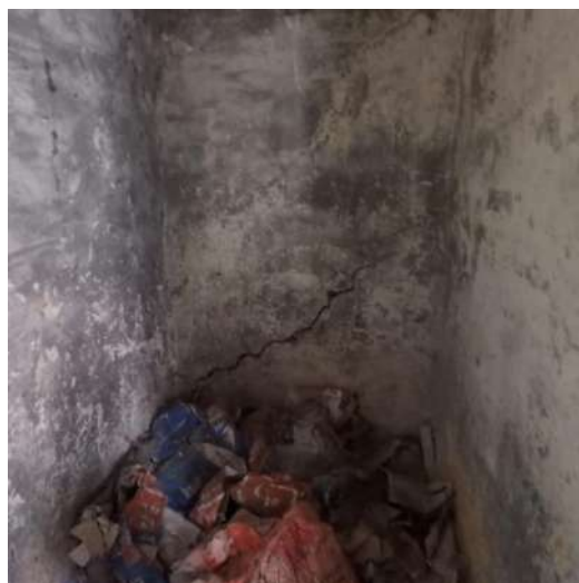
vleugel [5]: zettingsscheur
