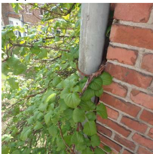
straatzijde: afvoer wordt met ijzerendraad vastgehouden
