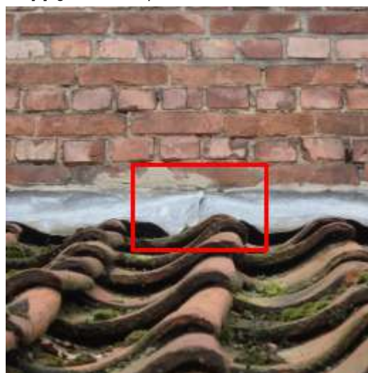
dak [5]: de loodslabben overlappen elkaar minimaal
