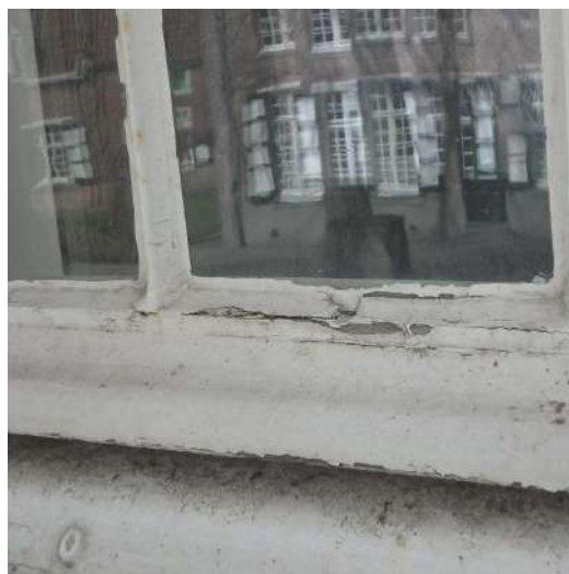
stopverf scheurt los
