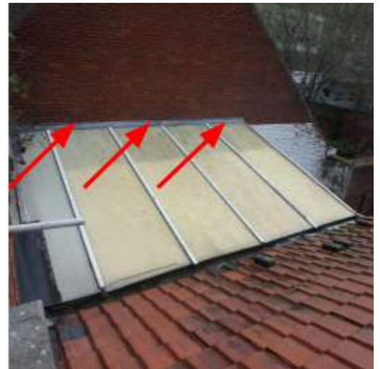
loodaansluiting met buurwoning komt los
