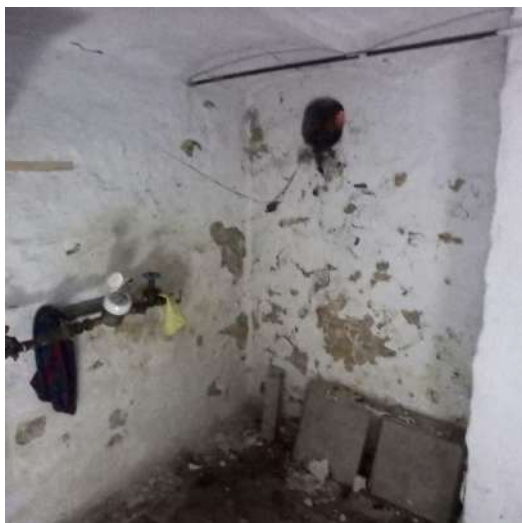
beschadigd pleisterwerk
