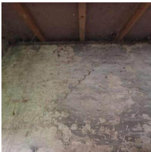
vleugel [5]: zettingsscheur
