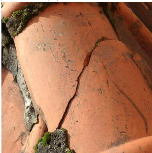
gebroken hoekkeperpan
