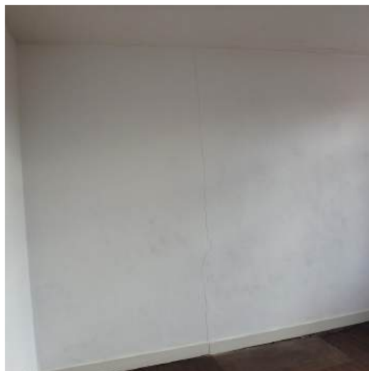
scheurvorming
