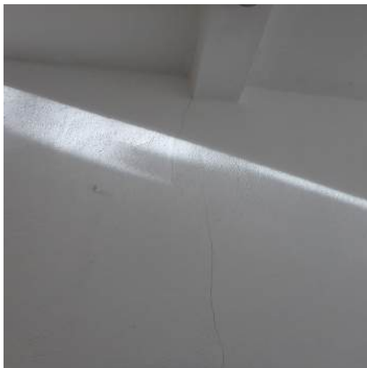
structurele scheur
