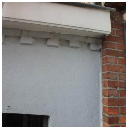
lichte scheurvorming
