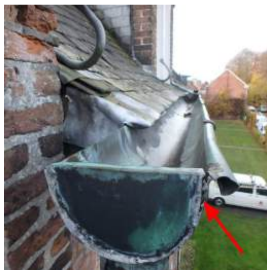
sterk verweerd koper en ingescheurde soldeer
