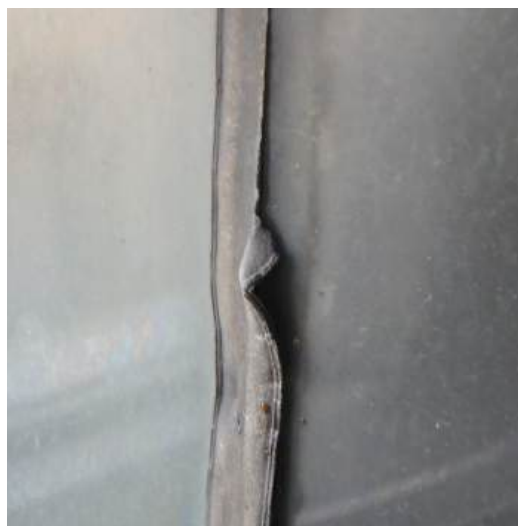
het loodnet is sterk verweerd en komt los
