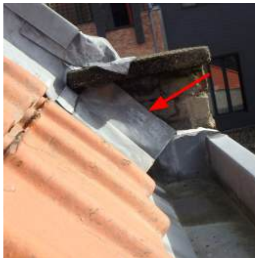
loodslab is koud tegen de gevel geplaatst
