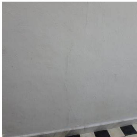
structurele scheur
