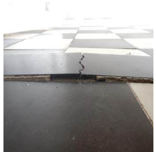
opgedrukte en gebroken deurdorpel
