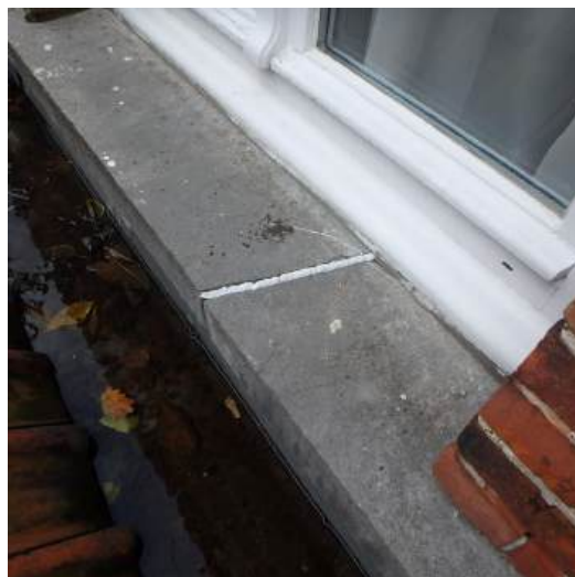
gebroken dorpel en kit scheurt terug los
