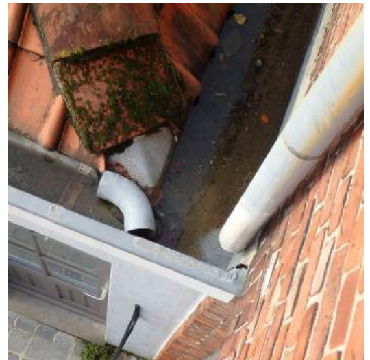
weggefallen bochtstuk werd teruggeplaatst
