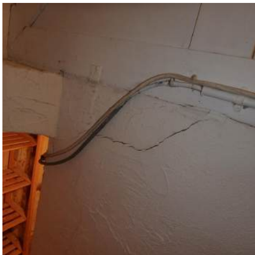
scheurvorming
