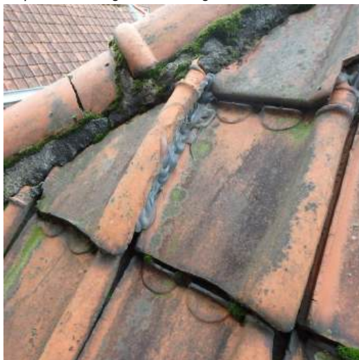
herstelling met kit uitgevoerd
