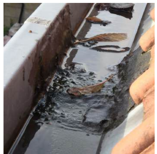
een herstelling begint terug los te scheuren
