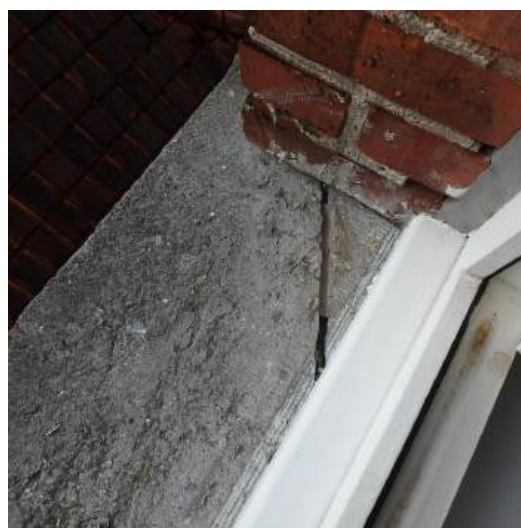
gebroken dorpel en slordige kitherstelling
