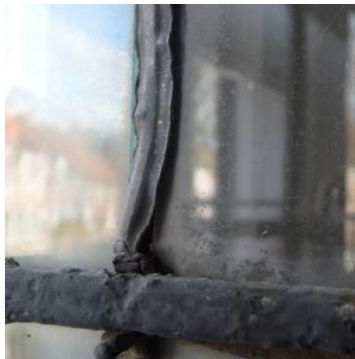
het loodnet is sterk verweerd, zakt uit en komt los
