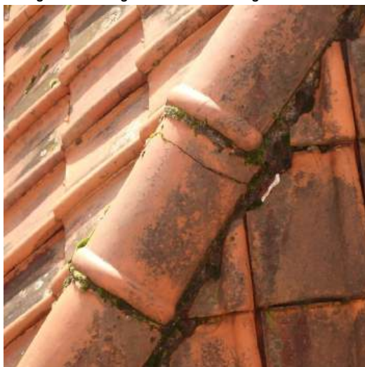
gebroken hoekkeperpan
