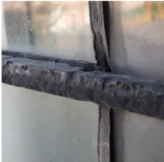
het bint lood zakt uit waardoor het glaasje los zit
