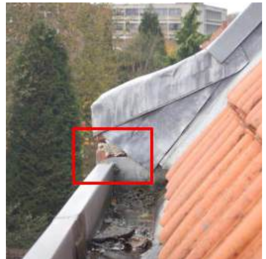
de kopse kant is niet afgewerkt
