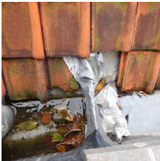
slordige aansluiting met de buurwoning
