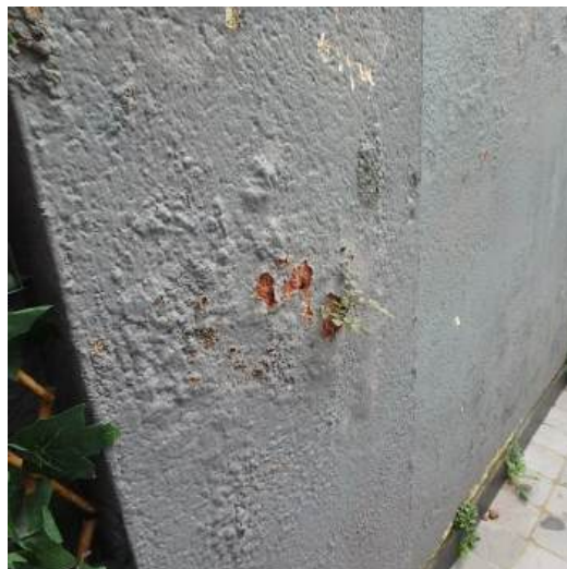
dampdichte verf bladdert af
