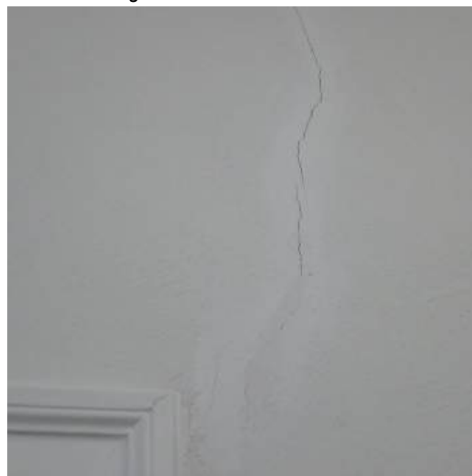
structurele scheur
