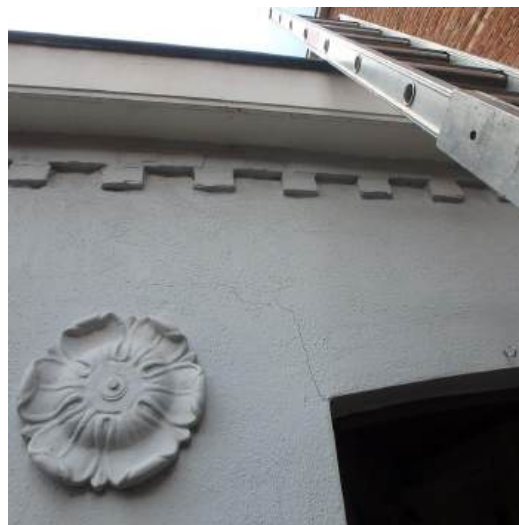
lichte scheurvorming
