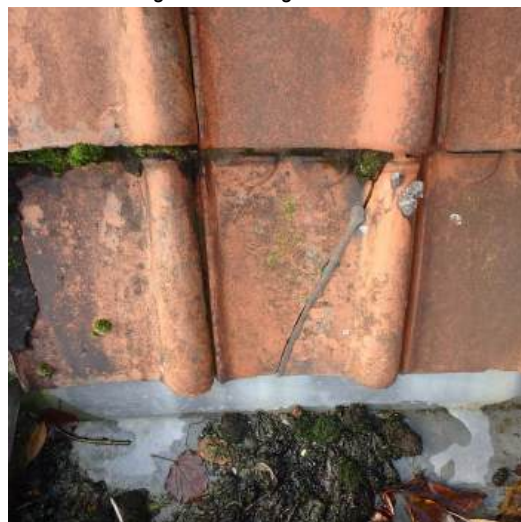
herstelling met kit uitgevoerd
