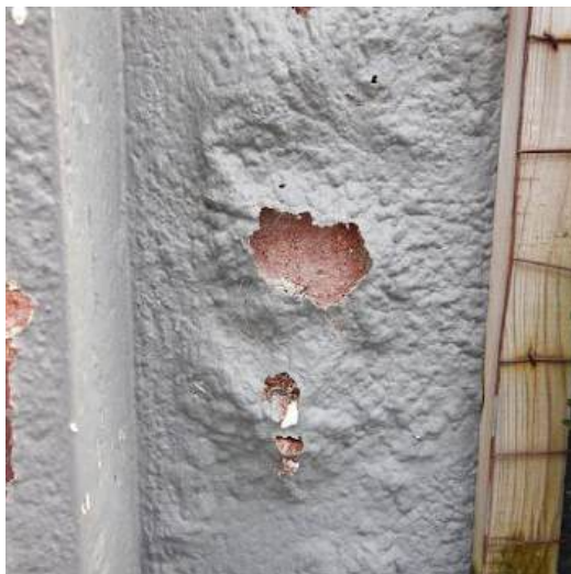
dampdichte verf bladdert af
