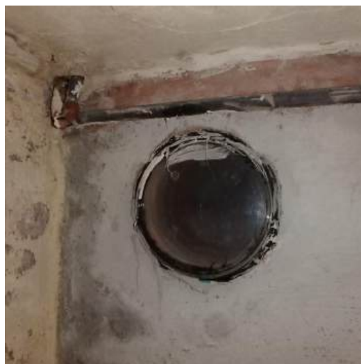
verluchting afgesloten
