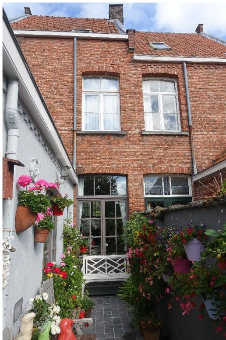
Afbeelding 18: Overzicht van de achtergevels
