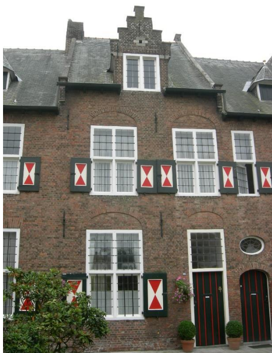
Afbeelding 11: Overzicht van de voorgevel
