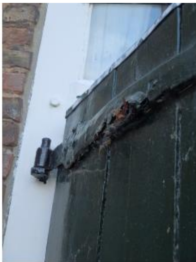
Afbeelding 65: Roestig hengsel
