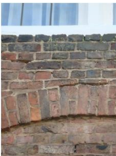
Afbeelding 57: Uitgespoeld voegwerk
