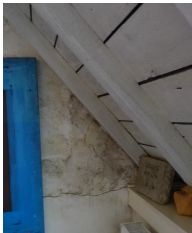
Afbeelding 76: Verregaande aantasting op de linker scheimuur
