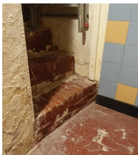
Afbeelding 44: zicht op de vloer, trap en betegeling
