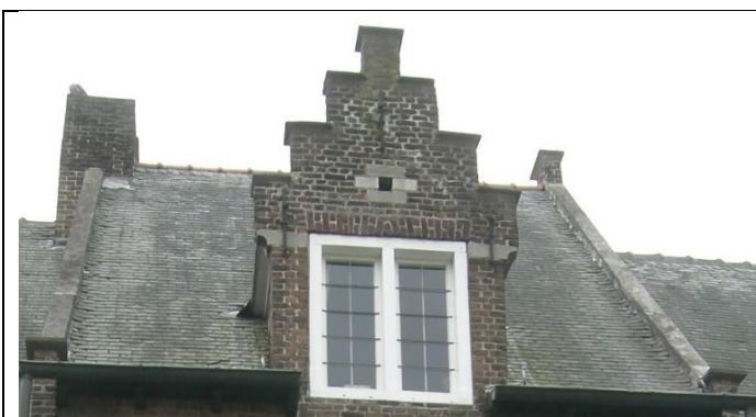
Afbeelding 67: Overzicht van het dak vooraan
