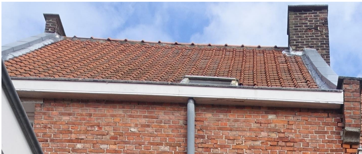
Afbeelding 23: Detail van de dakbedekking
