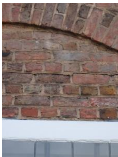
Afbeelding 56: Scheur boven het gelijkvloerse raam
