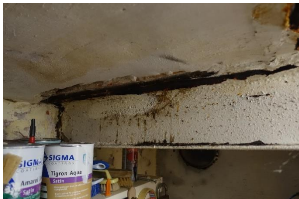
Afbeelding 72: roest aan een vrijliggend I-profiel
