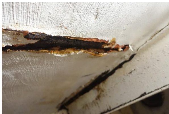
Afbeelding 73: Verregaande roest op een ligger tussen 2 gewelfjes
