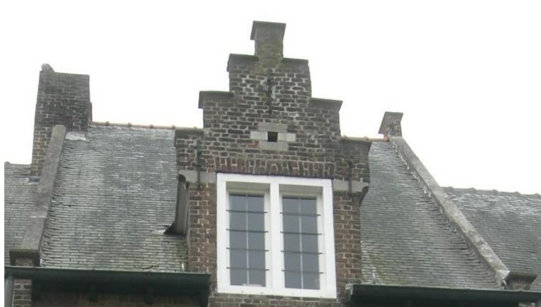
Afbeelding 16: Detail van het dak
