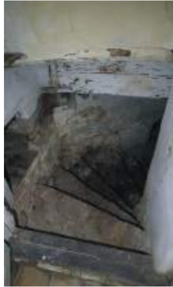
afb. 38: Bakstenen spiltrap.
