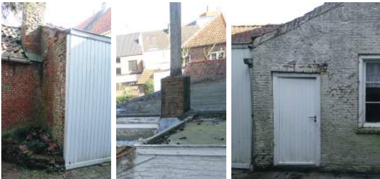
afb. 64: Storende elementen van de aanbouw: muurbekleding, schouwpijp en nieuwe deur: huidige toestand maart 2022.
