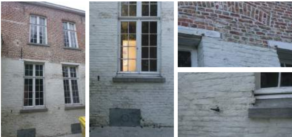
afb. 63: Kelderopeingen en restanten luikbeslag achtergevel: huidige toestand maart 2022.
