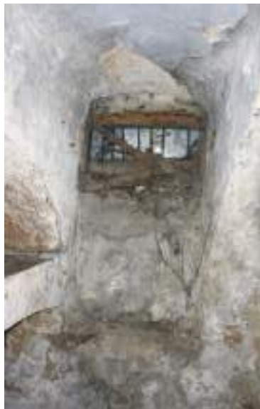
afb. 70: Losgekomen kalkpleister t.g.v. vochtinfiltratie: kelder, huidige toestand maar 2022.
