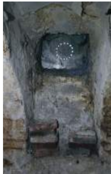
afb. 70: Losgekomen kalkpleister t.g.v. vochtinfiltratie: kelder, huidige toestand maar 2022.
