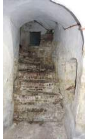
afb. 39: Nieuwe betonnen gewelfsels.
