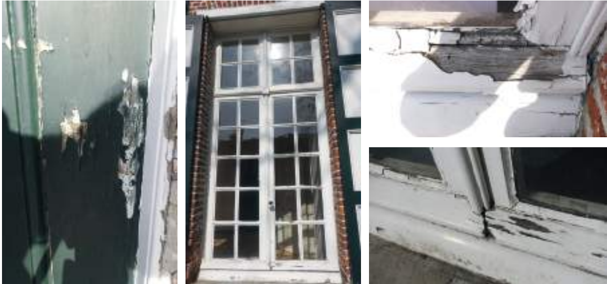
afb. 62: Schrijnwerk voorgevel: huidige toestand maart 2022.
