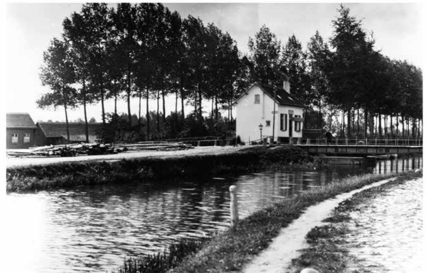
+ Brug 1 kanaal Dessel - Turnhout - Schoten (foto genomen aan de oostkant)
