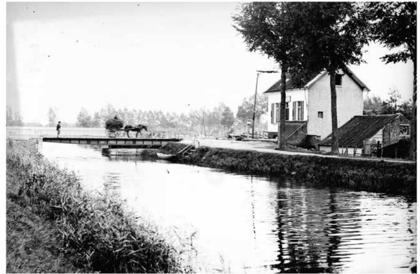
+ Brug 1 kanaal Dessel - Turnhout - Schoten (foto genomen aan de westkant)
